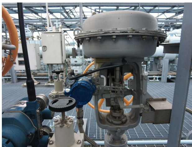
ひびき LNG 基地と「Dx Valve Cloud Service」を構成する当社スマート・バルブ・ポジションナ(写真右)
