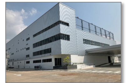
▲ アズビルプロダクション タイランド 新工場棟
