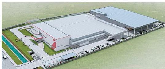
▲ タイ工場 新棟建設（2017年竣工）
