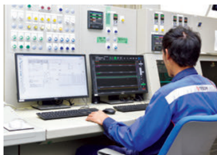
中央監視室に設置された「BiG EYES」の端末。監視モデルを作成するコンフィギュレータ画面（左）とトレンド監視ビューア（右）
