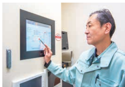
九段小学校・幼稚園様の施設全体の空調を中央集中型で管理しているsavic-netFX2compact。この中央監視装置がアズビルのBOSSセンターと接続し遠隔から施設の設備の状態を監視する。
